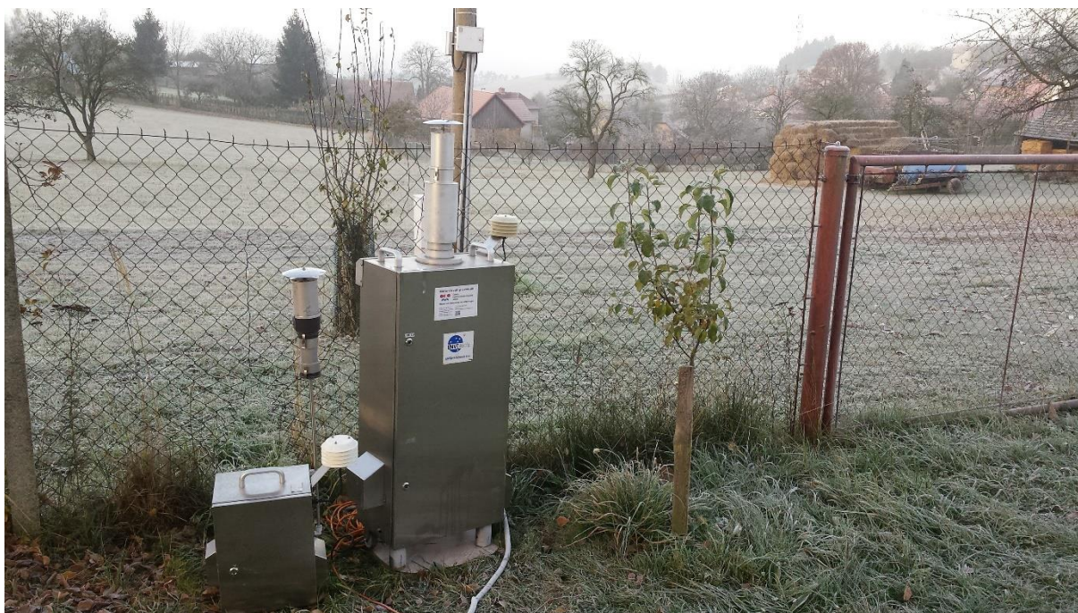
Obr. 7 Vybudovaná monitorovací stanice v Stříteži
